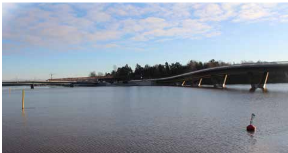
Byggnadsställningarna runt Finkes bro har rivits. Till vänster finns bron till Högholmen och i bakgrunden vänster om Högholmen skimtar Kronbergens arbetsplats. Bild: J-P Lumilahti
