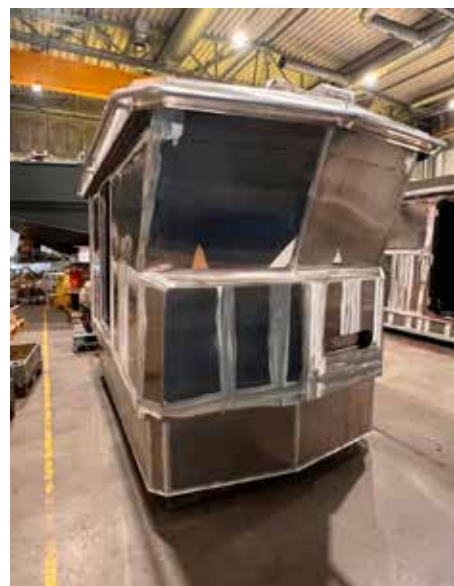
Den nya räddningsbåtens hytt tar form hos Kewatec.
