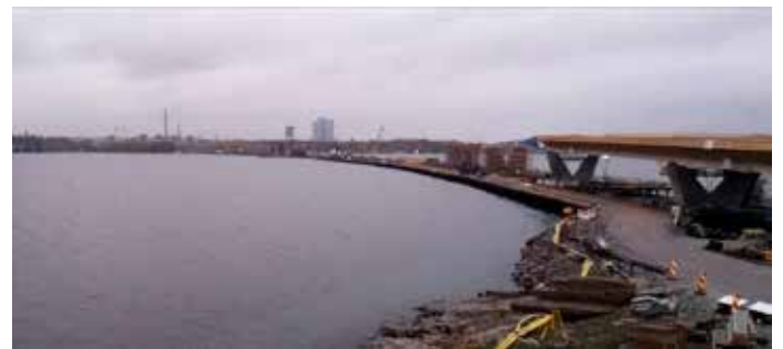
Kruunuvuorensillalla on jo näkyvissä siltarakenteita Laajasalon puolella. Kuvakaappaus Kruunusiltojen työmaakamerasta 14.10.2022
