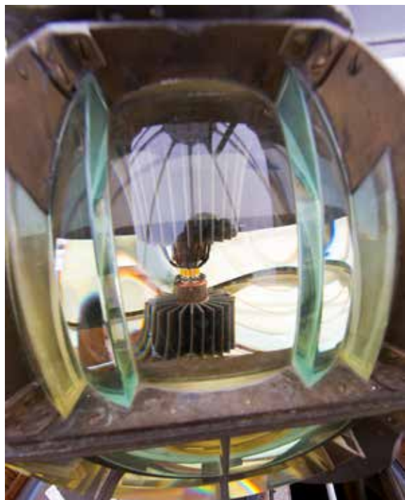
Remontin yhteydessä valonlähteeksi vaihdettiin uusi LED-valo. Itse valonlähde on todella pieni verrattuna sen ylä- ja alapuolella oleviin jäähdytysripihin.
