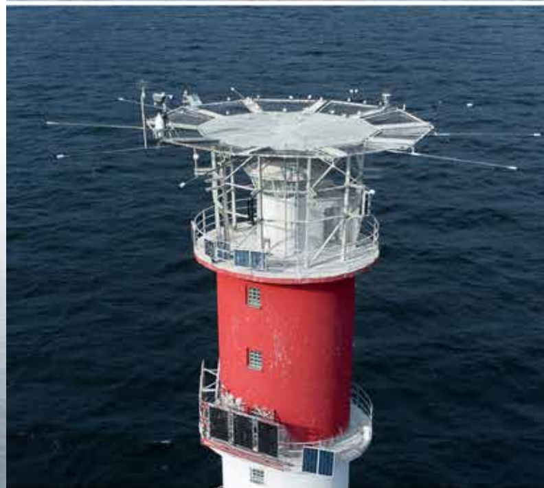
Vuonna 1984 majakan päälle rakennettiin helikopteritaso. Kuvat: Markku Tamminen.
