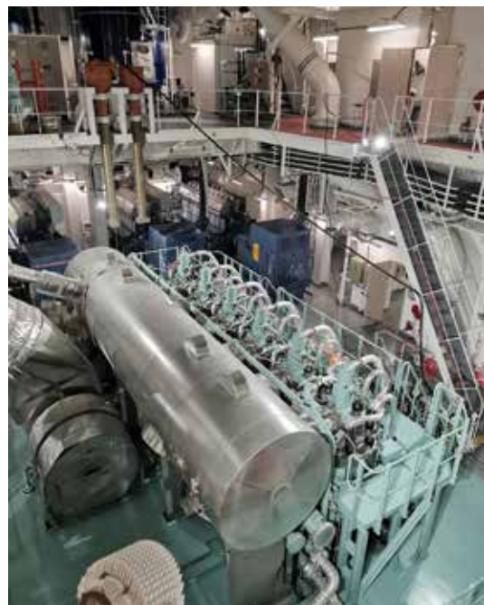
Konehuoneessa tehdään viimeistelytyötä.
