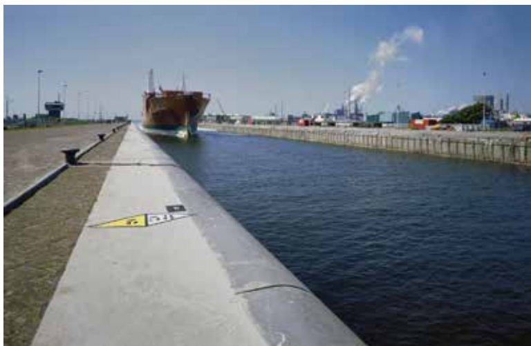
Sulun reunalla olevat merkinnät auttavat antamaan komentosillalle tietoa laivan paikasta. Merkinnät ovat 10 metrin välein. Kuva R. Hoogewoud
