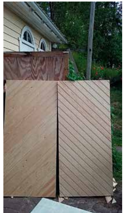
Vajan ovet tehtiin uusiksi tarkalleen vanhojen ovien mukaisiksi. Kuva: Matti Mitra
